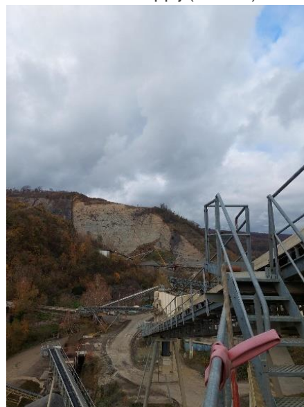
View of technical installations at SOCIETE D'EXPLOITATION DES CARRIERES D'YVOIR SA
